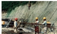
起こし作業中
