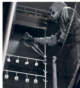
スプレーガンによる塗布作業
