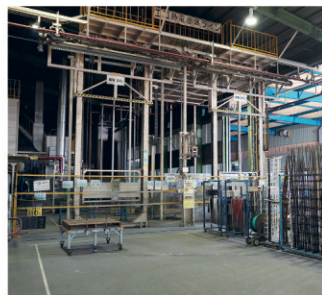
指定色塗装を行う設備
