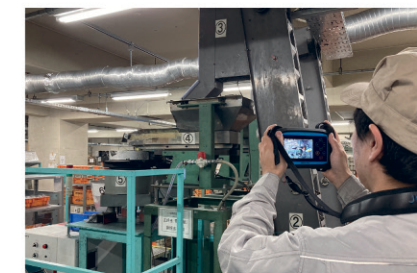
「エアリークビューアー」を使用してエアリークを点検しています。
