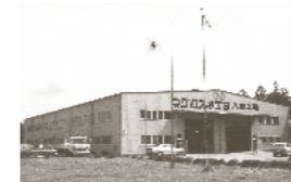
昭和48年 第3工場(現・八街工場)
