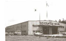
昭和48年 第3工場(現・八街工場)
